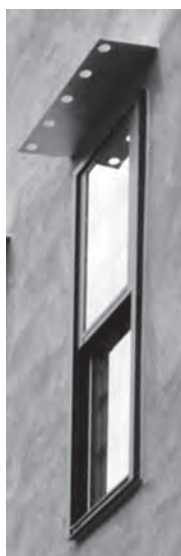
写真20 K町の縦長窓と庇
