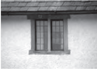
写真7 大屋根直下の窓
