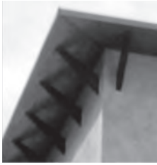
写真21 K町の家 玄関上庇の肘木
