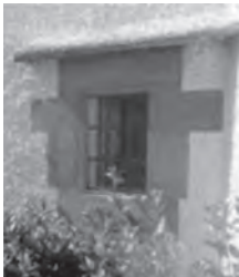
写真10 枠取りの四角い窓と左官仕上げの薄い庇
