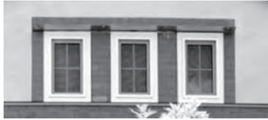
写真23 S町の家、窓まわりのフレーム
