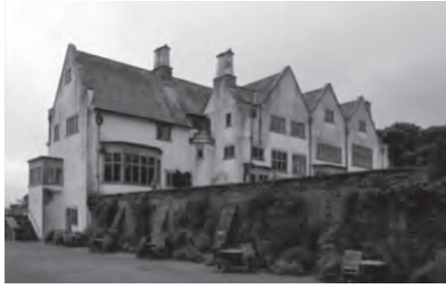
写真3 BLACKWELL HOUSE のファサード
