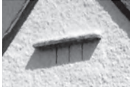
写真12 庇状の妻飾り
